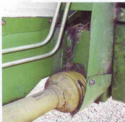
Eine Schweißstelle im Bereich des Dosierwalzenantriebs weist auf starke Beanspruchung hin.
